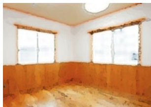
内装の木質化
